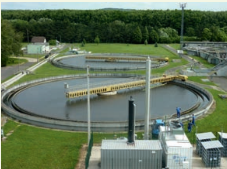
Fotografia 1 – Stație de epurare a apelor uzate (Ungaria)
