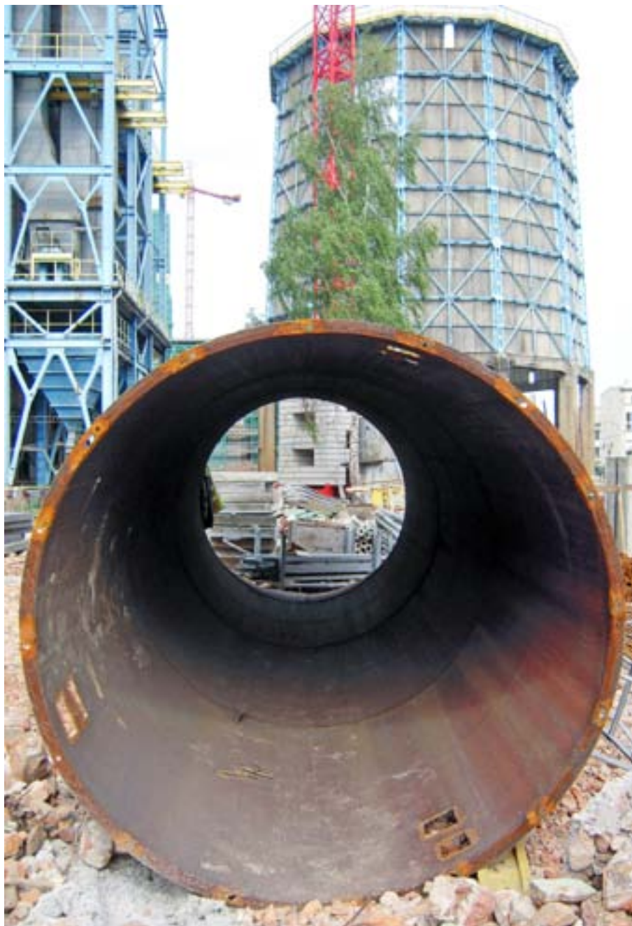
Zdjęcie 1 – Renowacja i adaptacja symbolicznej wieży w centrum miasta znajdującej się na terenie zrujnowanej elektrowni, która jest przekształcana w centrum kultury i sztuki (Łódź, Polska)
