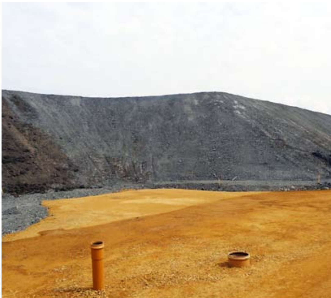
Foto 10 — Grond is gereedgemaakt voor de aanleg van wegeninfrastructuur op de heuvels van mijnafval van een voormalige steenkolenmijn (Jaworzno, Polen).
