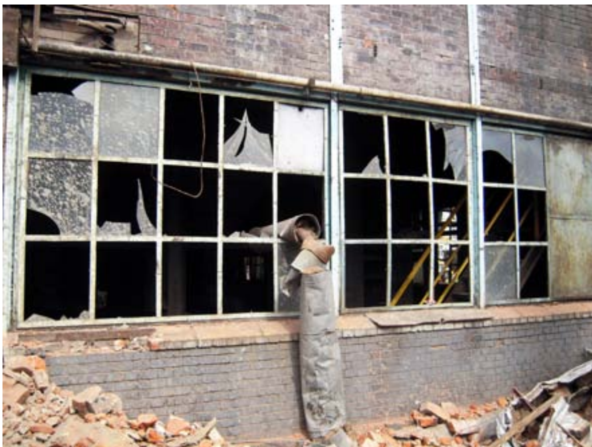
8. fotoattēls. Vecu ēku nojaukšana un rekonstrukcija pamestas spēkstacijas teritorijā, ko pārveido par mākslas un kultūras centru (Lodza, Polija)
