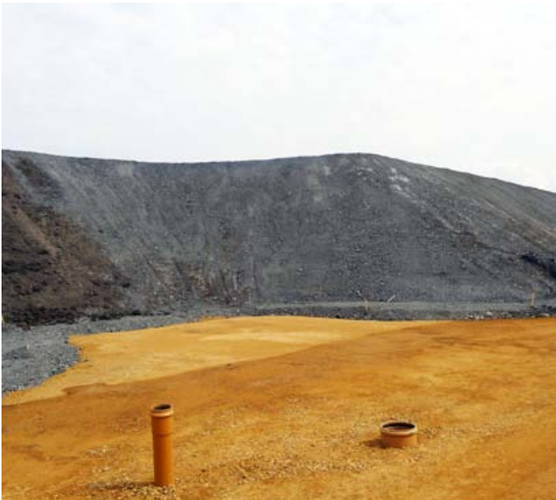
10. fotoattēls. Ceļa infrastruktūras celtniecībai sagatavotā zeme bijušajā akmeņogļu izdedžu grēdu teritorijā (Javorzno, Polija)
