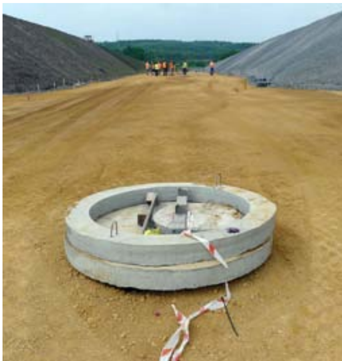
Photo 4 — Construction de routes et d'installations collectives sur le site d'un ancien terril (Jaworzno, Pologne)
