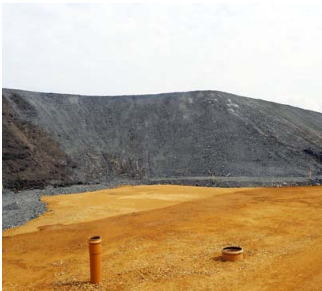
Photo 10 — Terrain préparé en vue de la construction d'une infrastructure routière sur le site d'un ancien terril (Jaworzno, Pologne)
