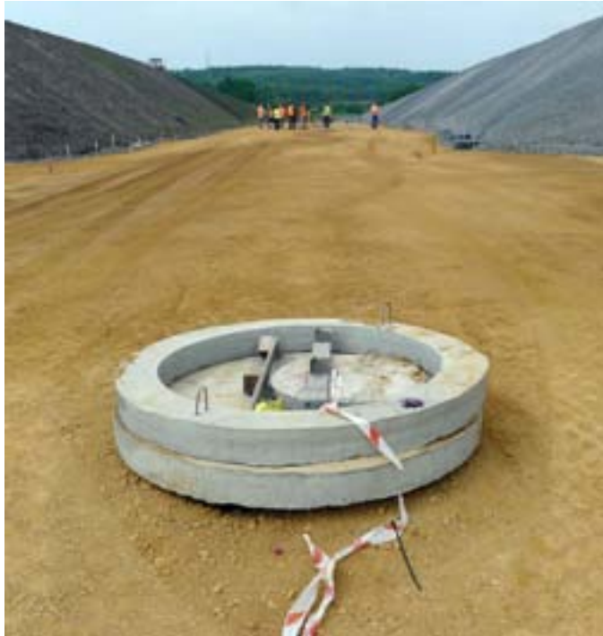
Kuva 4 – Rakenteilla olevia teitä ja yleishyödyllisiä laitteistoja entisen hiilikaivoksen kaivosjätealueella (Jaworzno, Puola)
