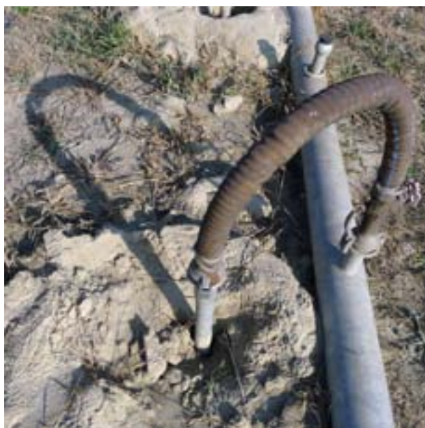
Fotografía 2: Tubería para la inyección de productos de limpieza en terrenos contaminados de una acería (Dunaujvaros, Hungría)
