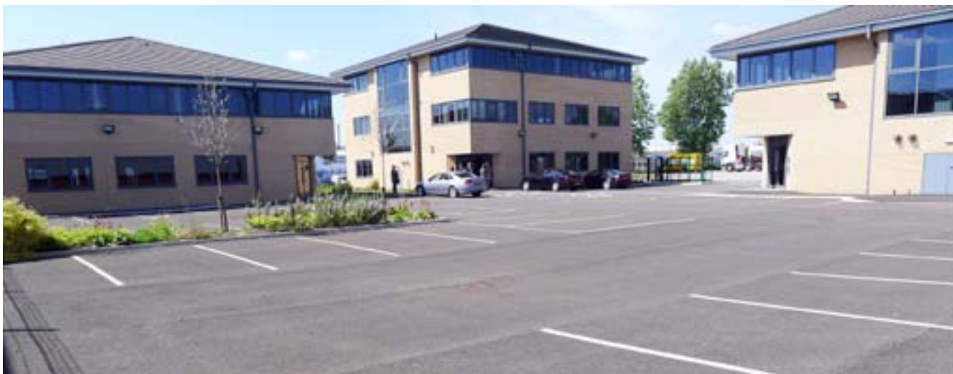
Fotografía 6: Oficinas listas para ser ocupadas construidas en el emplazamiento de una antigua fábrica de productos químicos (Widnes, Reino Unido)
