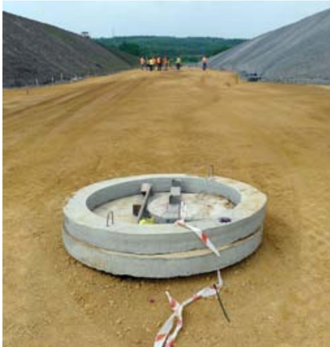
Fotografía 4: Construcción de instalaciones para carreteras y servicios en el escorial de una antigua mina de carbón (Jaworzno, Polonia)
