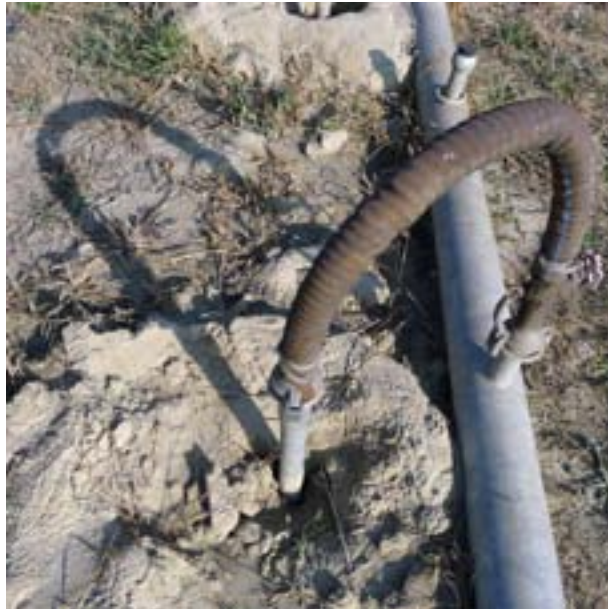
Φωτ. 2 — Αγωγός που εγχέει υγρά καθαρισμού στο μολυσμένο έδαφος χαλυβουργίας (Dunaujvaros, Ουγγαρία)
