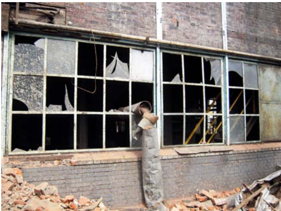
Снимка 8 — Разрушаване и преустройство на стари сгради в изоставена електроцентрала, която се преобразува в център за изкуства и култура (Łódź, Полша)
