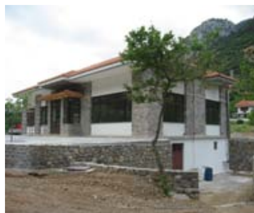
Снимка 9: Гърция — Изграждане и оборудване на таверна
