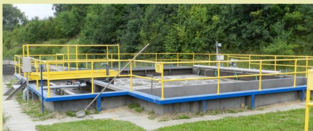
Construirea unui sistem de alimentare cu apă și de canalizare în Polonia (măsura 321, beneficiar public) Costuri eligibile: 936 289 de euro Finanțare publică: 68 %
