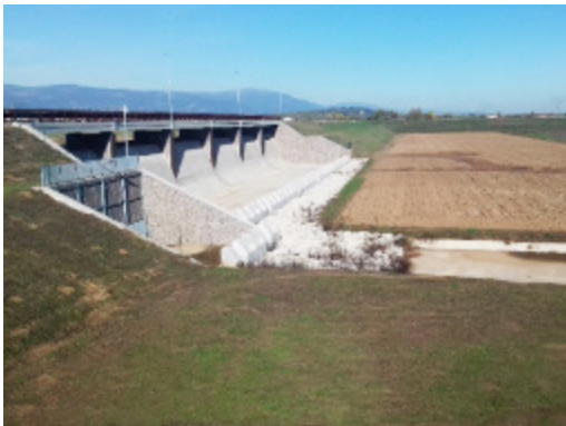
Reservatório seco utilizado para o armazenamento temporário de água a fim de reduzir o risco de inundação das localidades a jusante. Os 110 hectares do reservatório são também utilizados para atividades agrícolas (Itália).
