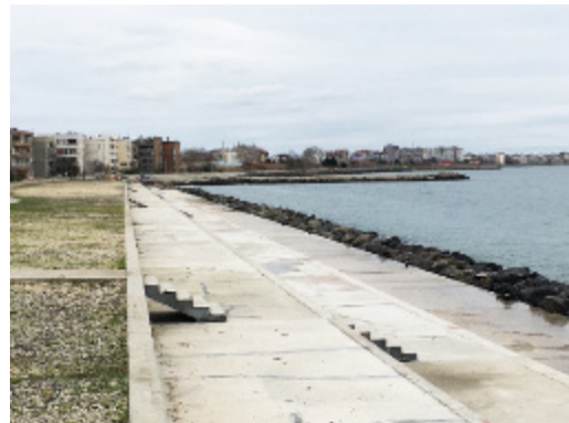
Talude costeiro para evitar a inundação de uma zona residencial. A altura do talude pode ser aumentada no futuro, caso aumente o perigo de inundação (Bulgária)
