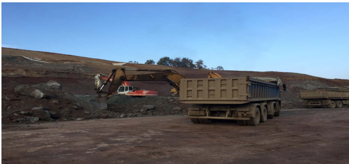
Figuur 7 – Bouwwerkzaamheden voor de centrale autosnelweg E-65 in Griekenland
