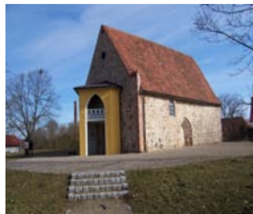
Foto 3: Germania (Mecklenburgo-Pomerania Anteriore) - Restauro di una chiesa, comprensivo di strutture turistiche
