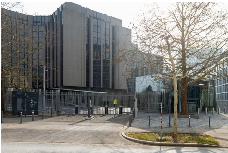
Das EuRH-Hauptgebäude "K1" und das neue Sicherheitskontrollzentrum in der Rue Alcide De Gasperi, Luxemburg
