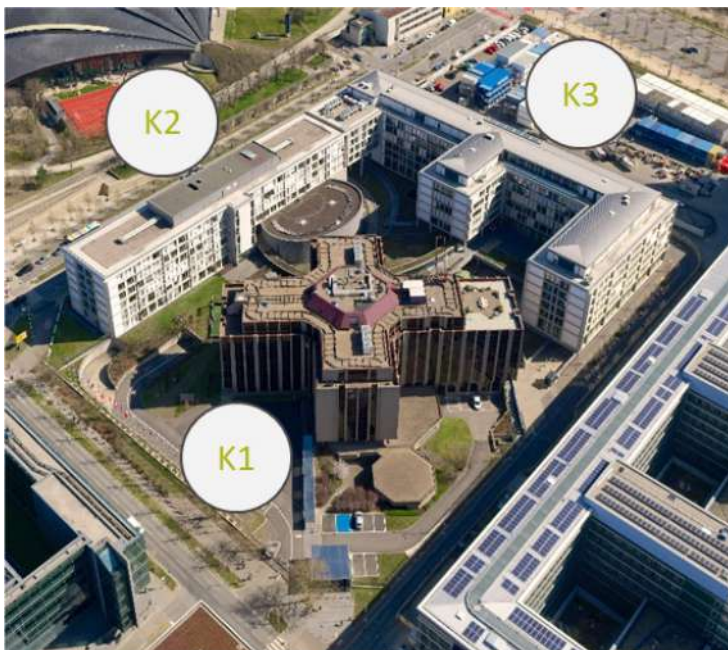
Figure 5 – Vue aérienne des bâtiments
